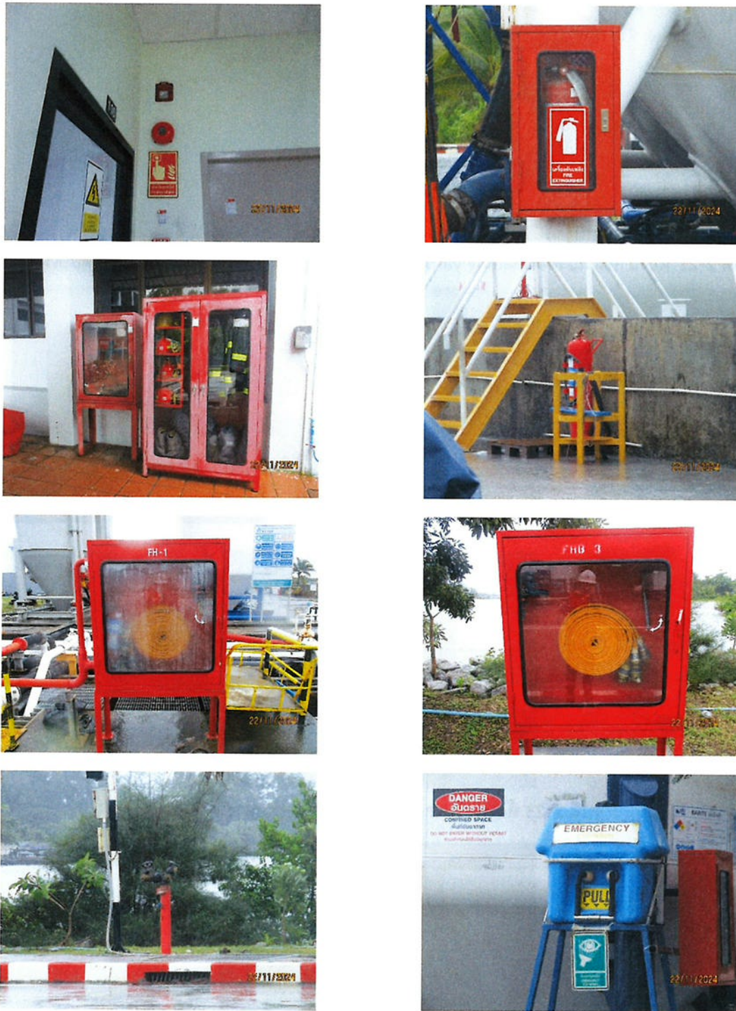
รูปที่ 2-25 อุปกรณ์และระบบเกี่ยวกับความปลอดภัยด้านอัคคีภัย
